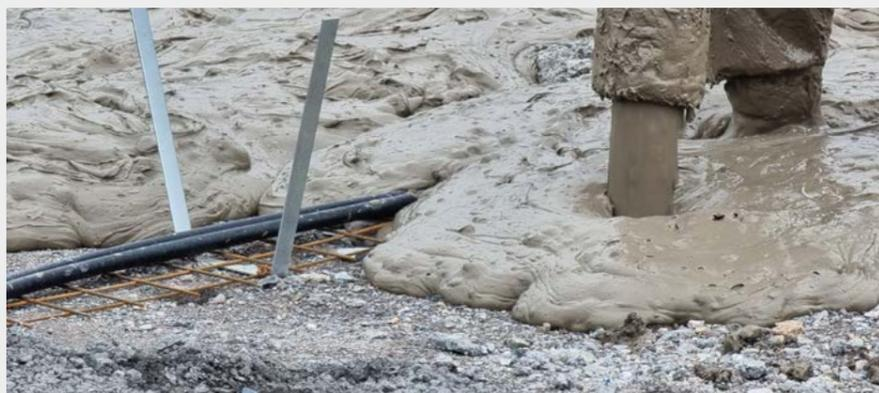
Ragazer Flüssigboden (RFB) im Einsatz: Der temporär fließfähige Baustoff ermöglicht ein schonendes und lückenloses Verfüllen – ideal zur sicheren Umhüllung von Leitungen und empfindlichen Bauteilen.
