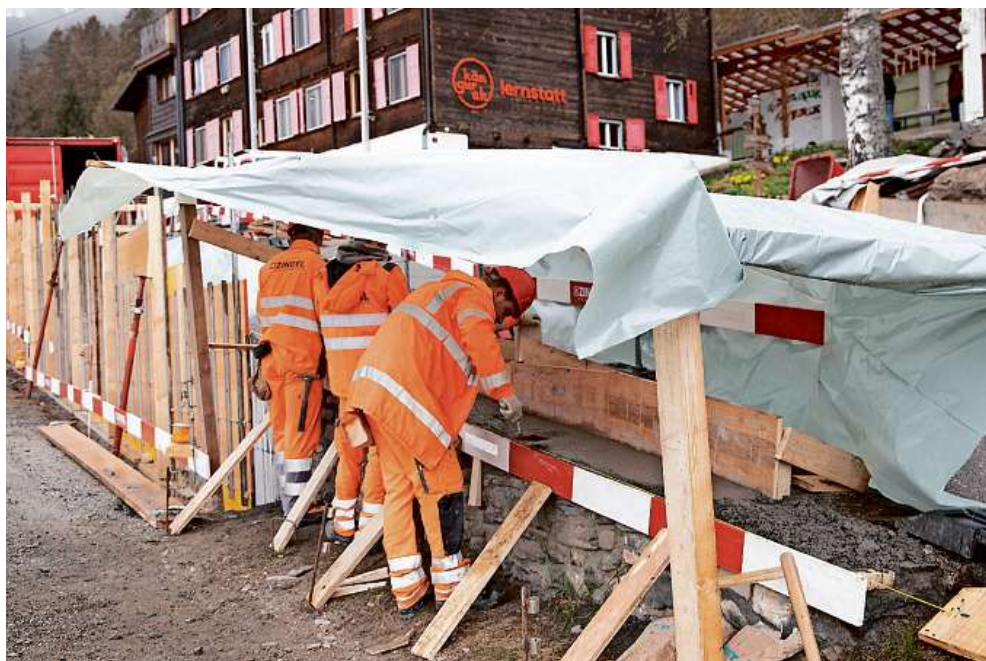
Einblick in eine Baustelle mit allem, was dazu gehört.
